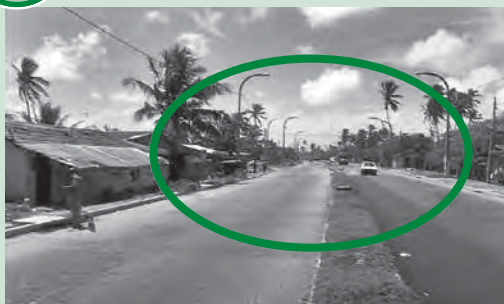
Antes da modificação
